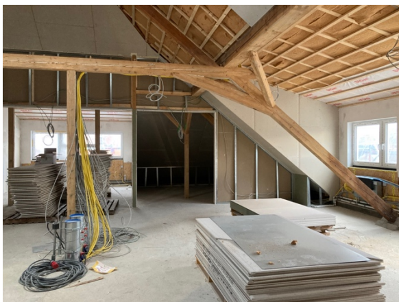
Dachgeschoss mit neuen Gauben
